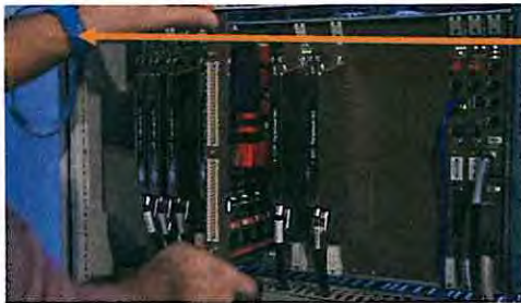
Рисунок 11. Изъятие неисправной платы ССМ/ССМ-Е
