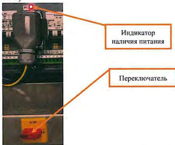
Рисунок 6. Отключение питания PSU151.
