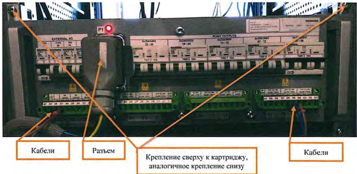
Рисунок 7. Отключение разъема и кабелей.
