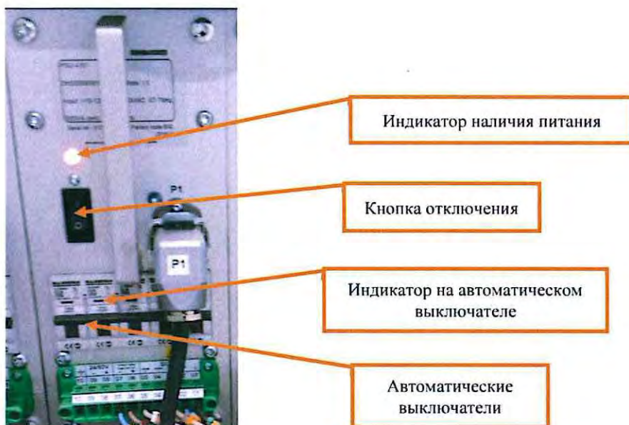
Рисунок 11. Отключение питания на PSU-410.
