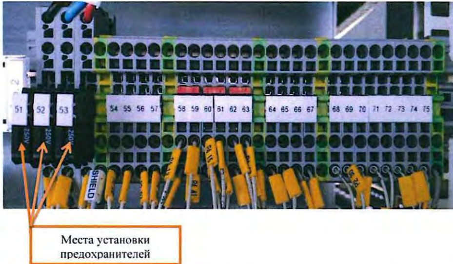
Рисунок 28. Места установки предохранителей для модуля МУЭП.
