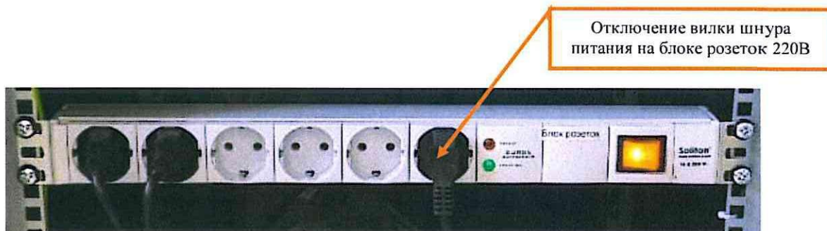
Рисунок 16. Отключение питания системного блока
