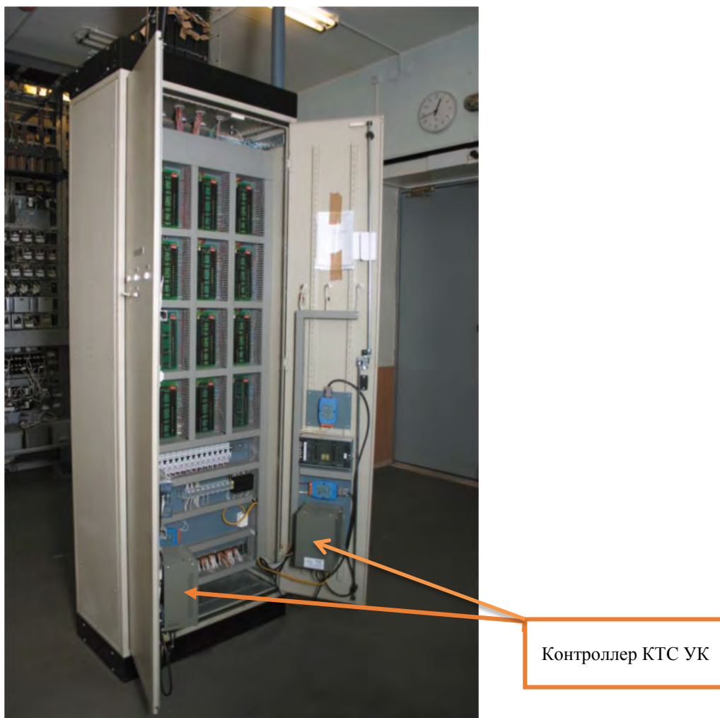
Рисунок 3. Вариант установки контроллеров КТС УК на дверях.
