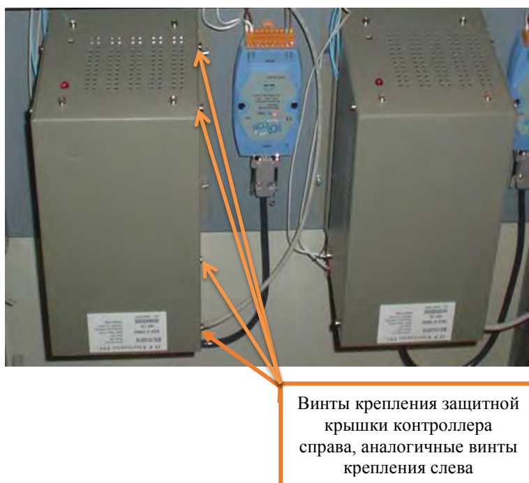
Рисунок 5. Крепление внешней защитной крышки контроллера.
