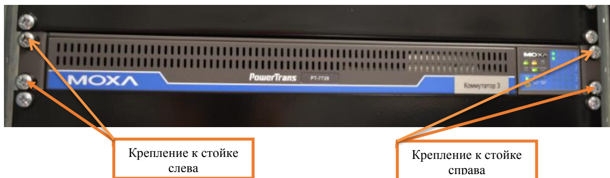
Рисунок 10. Крепление коммутатора.
