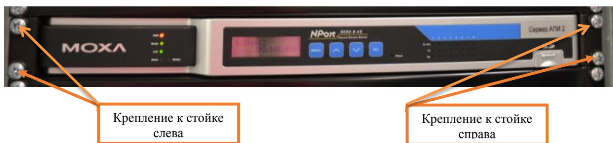
Рисунок 8. Крепление сервера АПИ.
